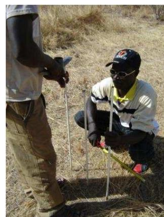
Photo 9 : piquetage de la largeur de la tranchée
