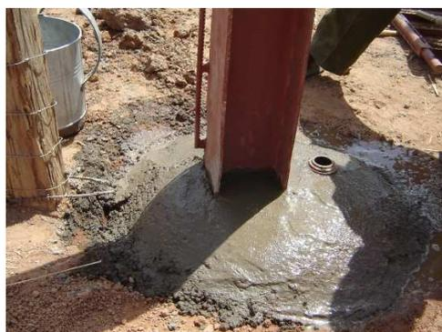
Photo 3 : cône d'étanchéité
