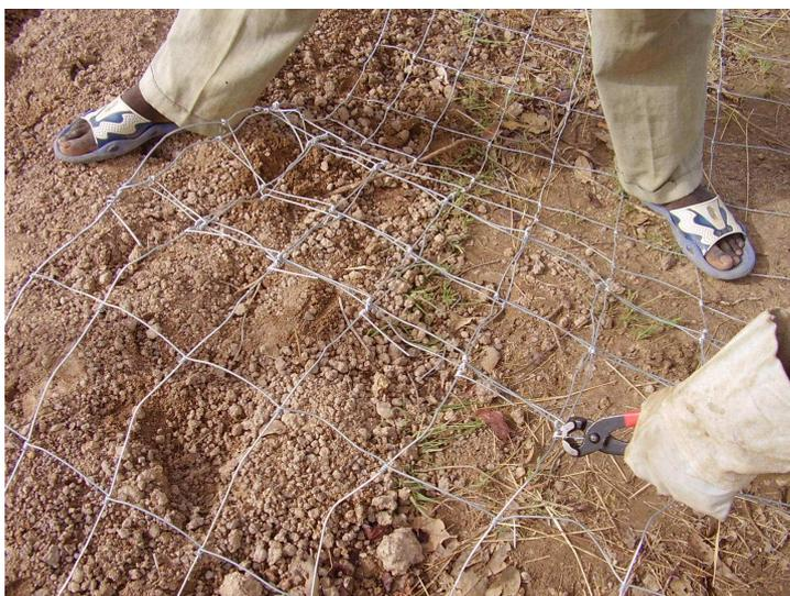
Photo 25 : réalisation d'un raccord de grillage
