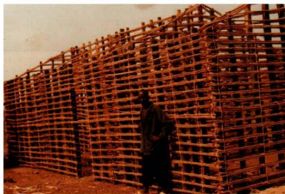
Fig. 52 : Constructions à base des stipes d' Hyphaene , maison à mur de planches d' Hyphaene soutenues par les Phragmites à l'aide des feuilles d' Hyphaene transformées en corde
